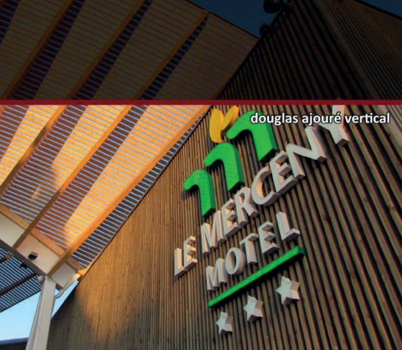
mélèze traité avec saturateur ton gris, largeurs variables
